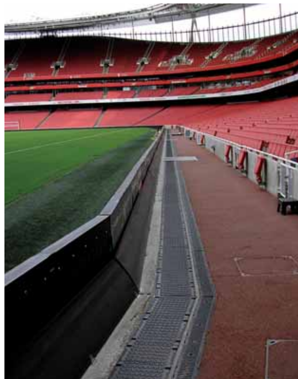
Сервисные каналы на стадионе Arsenal
